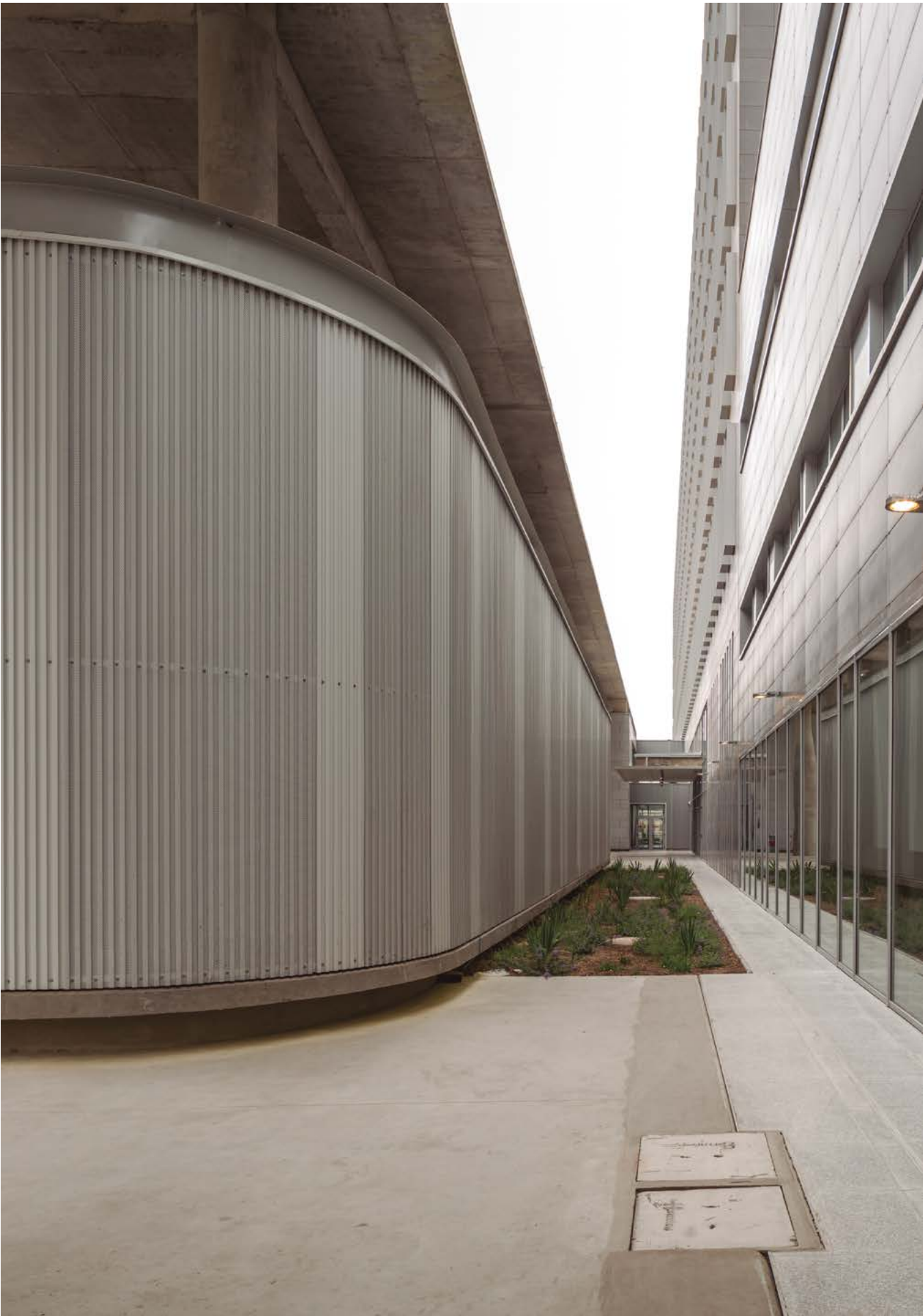
Hospital de Antofagasta - Arquitetos: Riesco Rivera Arquitectos, Carvajal Casariego, Iglesias Arquitectos - Produto: QuadroLines 30x15
