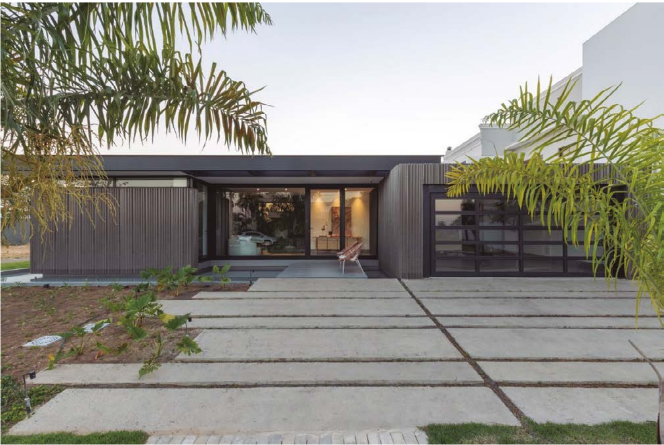
Casa GBC Platina Brasil - Arquitetos: Ecohaus Construções Sustentáveis - Produto: GeoClad
