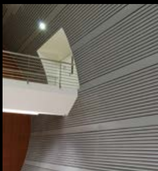
Revestimento 84R Pág. 146
