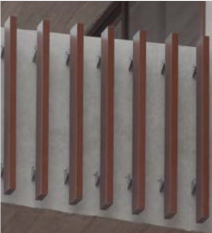
BRISE FINS 25 INSTALAÇÃO DENTRO DO VÃO
